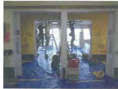
入居者の居室改修時、入居者の皆様には食堂でお過ごしいただきました。
