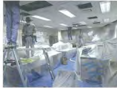
事務室や公共スペースの空調更新は、出勤職員が少ない日曜日に実施されました。
